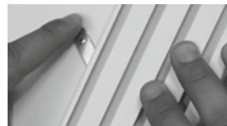
Deckenspanner montieren, Schiene von unten auf den Deckenspanner legen und diesen zum Fixieren der Schiene drehen
