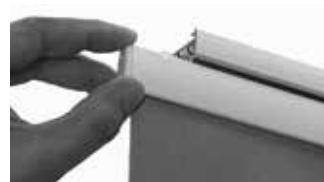
Paneelwagen seitlich in das Profil führen und Endkappe verschrauben
