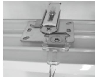
Die Demontage der Anlage erfolgt mittels Auslöseplatte. Verwenden Sie einen Schraubendreher und ziehen die Platte nach vorn. Die Schiene wird dadurch aus dem Deckenclip gelöst. Durch den entstandenen Raum lässt sich die übrige Schiene mittels Druck auf den Deckenclip einfach demontieren.
