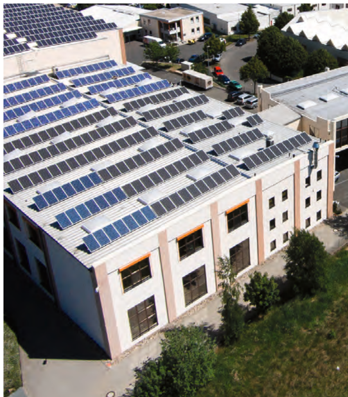
Um die kontinuierliche Verbesserung der energiebezogenen Leistung zu bestimmen, arbeitet erfal seit 2016 zertifiziert nach einem Energiemanagementsystem gemäß DIN EN ISO 50001.
