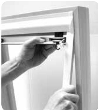
Achten Sie darauf, dass die Lippe der Unterleiste in der Öffnung der Seitenführung sitzt. Die Schnüre dürfen keinesfalls zwischen die Seitenführungen und den Rahmen gelangen.
