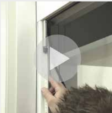
Insektenschutz – Elektrorollo ER2 Montage Zusatzanschlag
