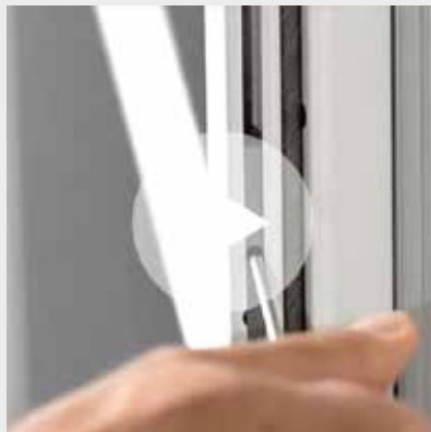
Insektenschutz – Pendeltür selbst aushängen
