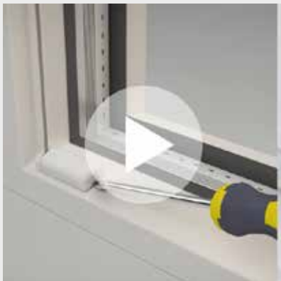
erfal VS2 Plissees - Demontage bei geraden & schrägen Fensterfalz
