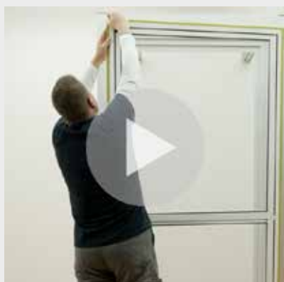
Insektenschutz – Pendeltür PT2/5 Klebmontage
