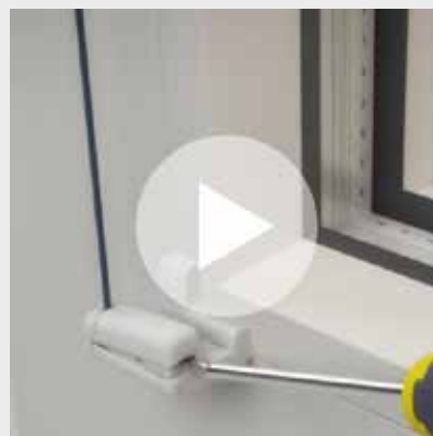
erfal VS2 Plissees mit Glasleistenwinkel - Demontage
