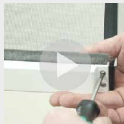
Insektenschutz – Elektorollo ER2 Gewebetausch
